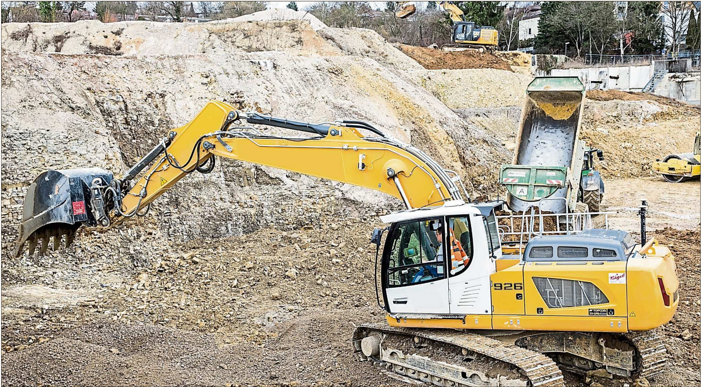
Auf ein ungewöhnlich niedriges Angebot für Erdarbeiten beispielsweise darf der Zuschlag nicht erteilt werden.
